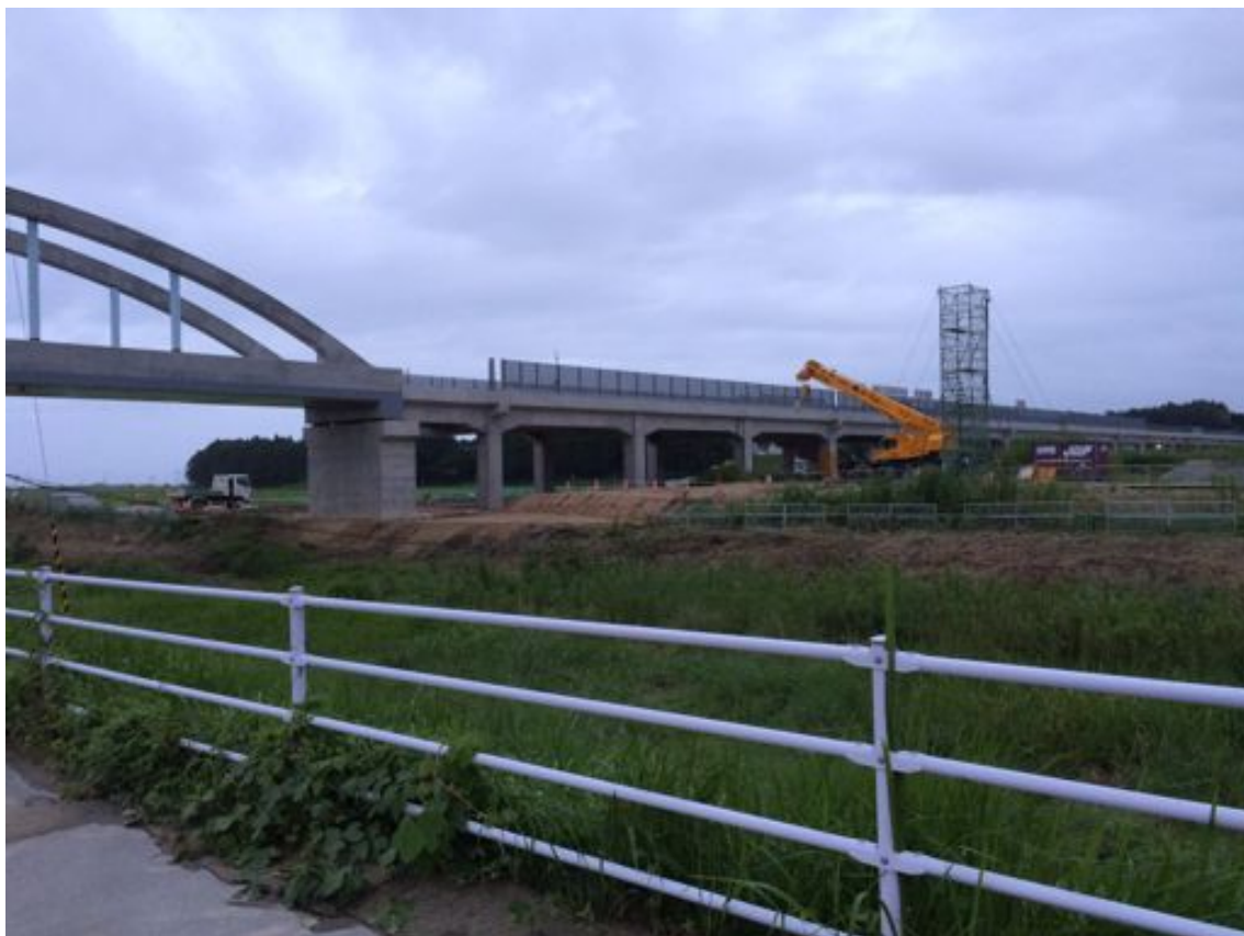
（写真・工事が進む山元町の坂元江駅）
